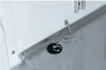
14 水抜き穴追加 (後左側)
